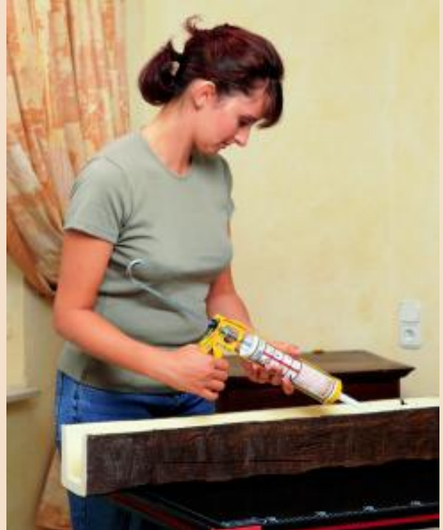
Kleber auf Balken-Rückseite auftragen. Eine Kartusche DECOSA Universalkleber reicht für ca. 10 m Balken.
