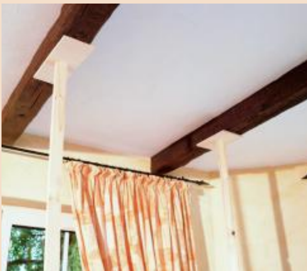
Balken mehrere Stunden lang abstützen.
