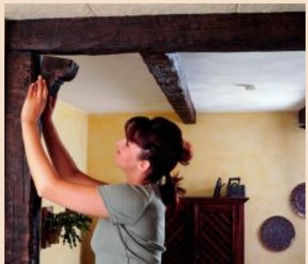
Zum Schluss Konsolen anbringen. Anschlüsse können mit Balkenbeschlägen oder Kitt und Beize kaschiert werden.
